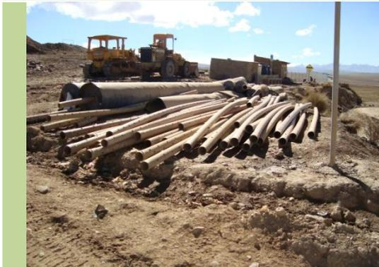
**Tuberías de PVC para lixiviados**
